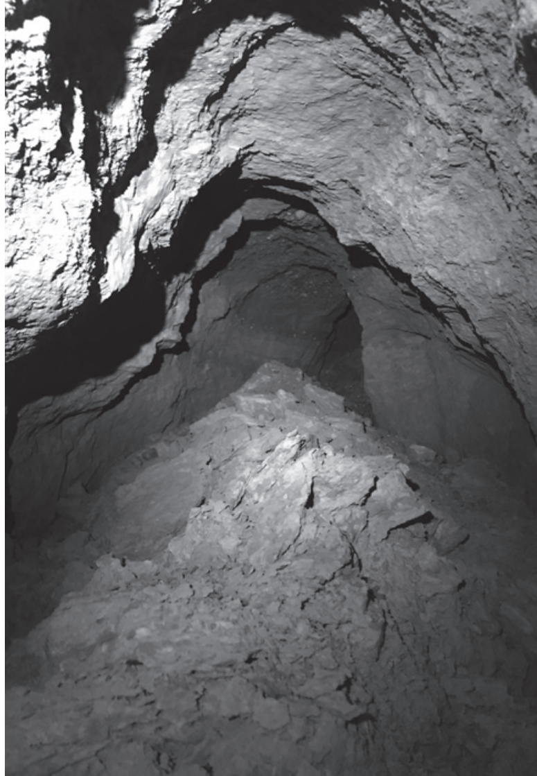
AFBEELDING 3: Horizontale deel van de zuidelijke vertakking van de graet, op het uiteinde wordt de tunnel geblokkeerd door een oude verzakking
